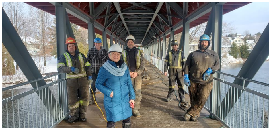
Mme Sylvie Blanchette, mairesse, tenait à remercier l'équipe présente sur le chantier. © Ville d'Amqui
